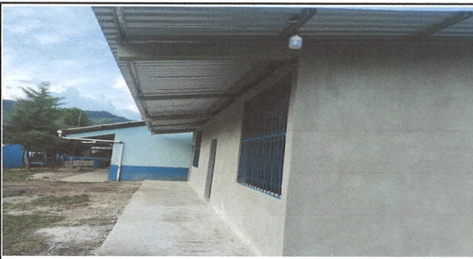
Foto 4: Mejoramiento de aula tipo portico
