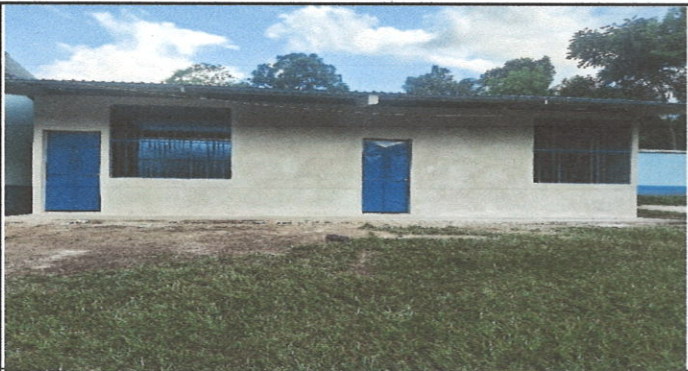
Foto 6: Mejoramiento de aula tipo portico
