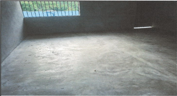
Foto 3: Mejoramiento de aula tipo portico
