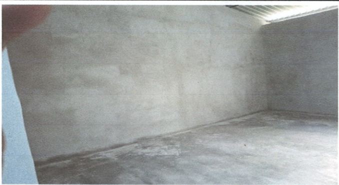
Foto 2: Mejoramiento de aula tipo portico
