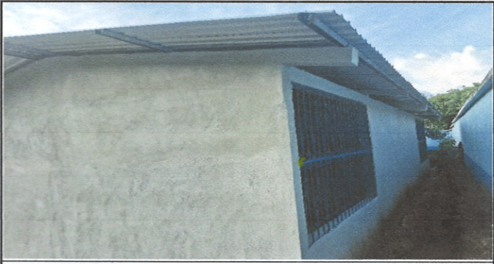
Foto 5: Mejoramiento de aula tipo portico
