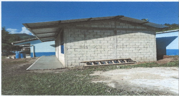
Foto1: Mejoramiento de aula tipo portico
